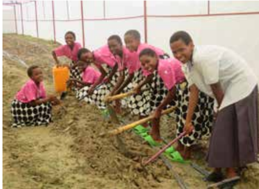
Meehelpen in de nieuwe serre in Kisarawe, april 2024
